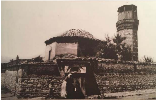
Üsküp Karakapıcı Camii onarımdan önce
