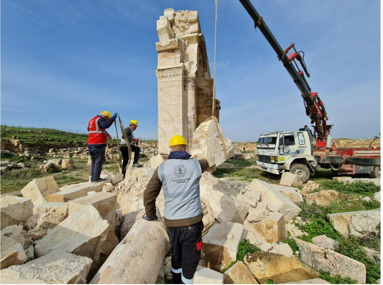
■ Fotoğraf 1: Harran Ulu Cami’de depremde yıkılan kemerin kaldırılması. Nisan 2023.
