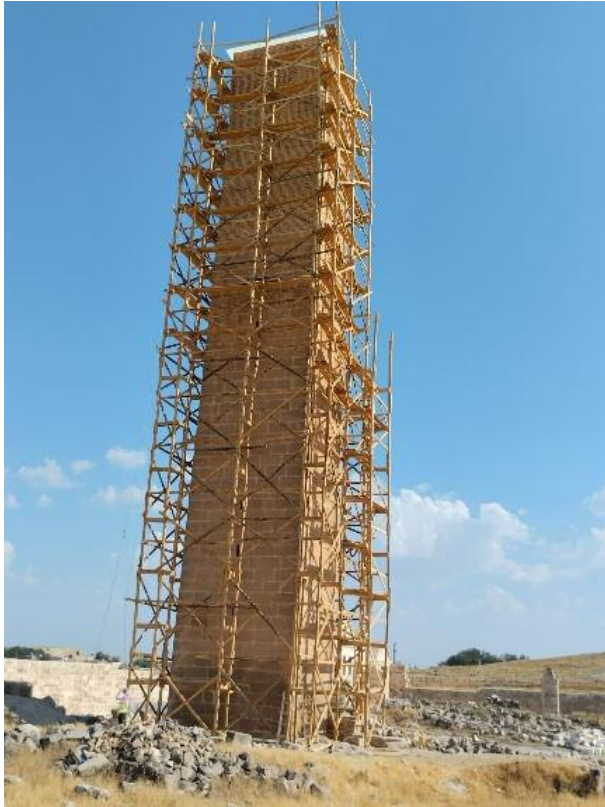
■ Fotoğraf 7: Harran Ulu Cami minaresinin restorasyonu yapılırken görünümü. (Temmuz 2023)
