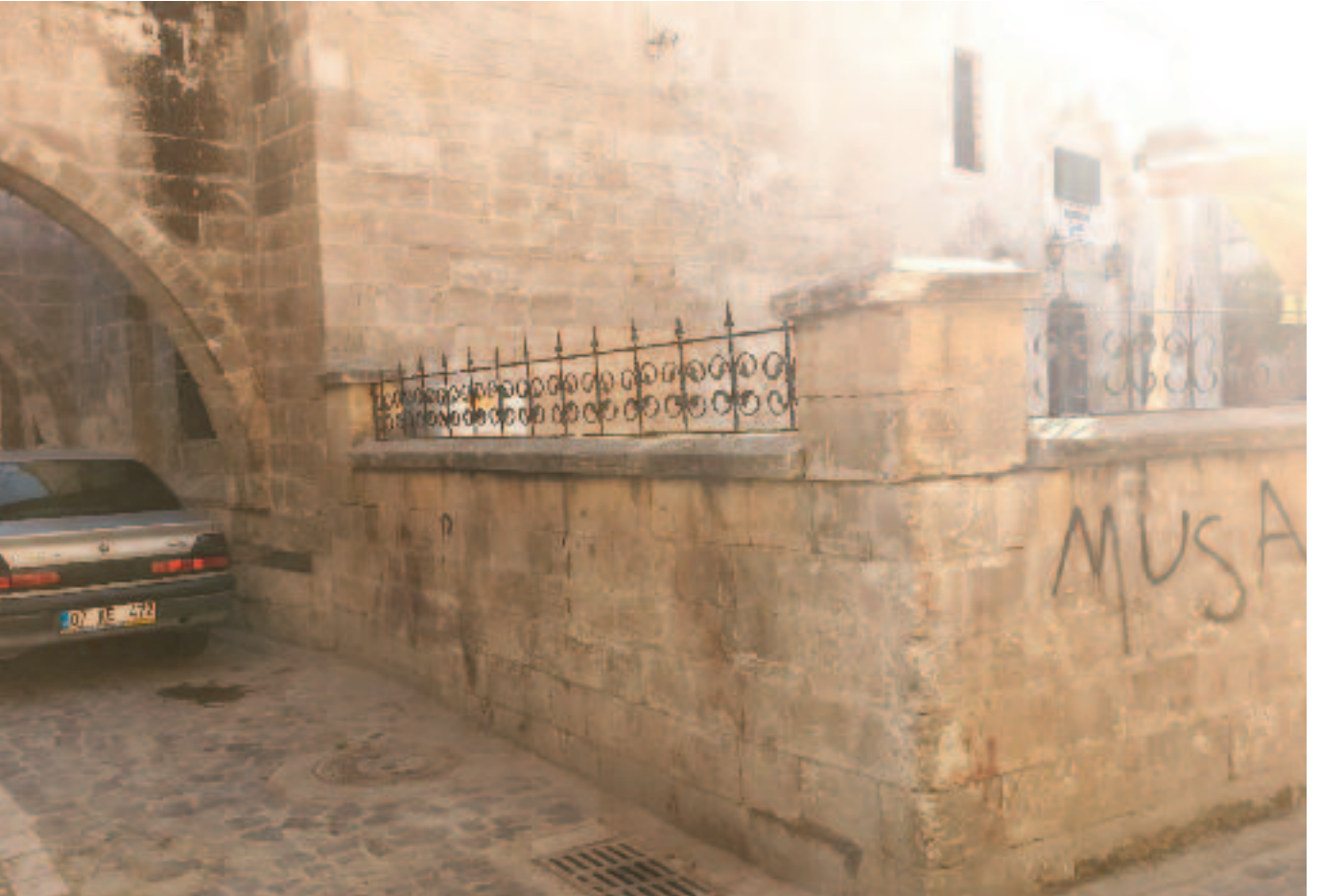
■ Cincıklı Hamam ile Hızanoğlu Camii arasında yer alan Cincıklı Değirmeni'nin olduğu yer caminin kuzeydoğu köşesinde yer alıyordu. Değirmenden çıkan su, Cincıklı Hamamı önünden devam ederek başka değirmenlere yol alıyordu.
