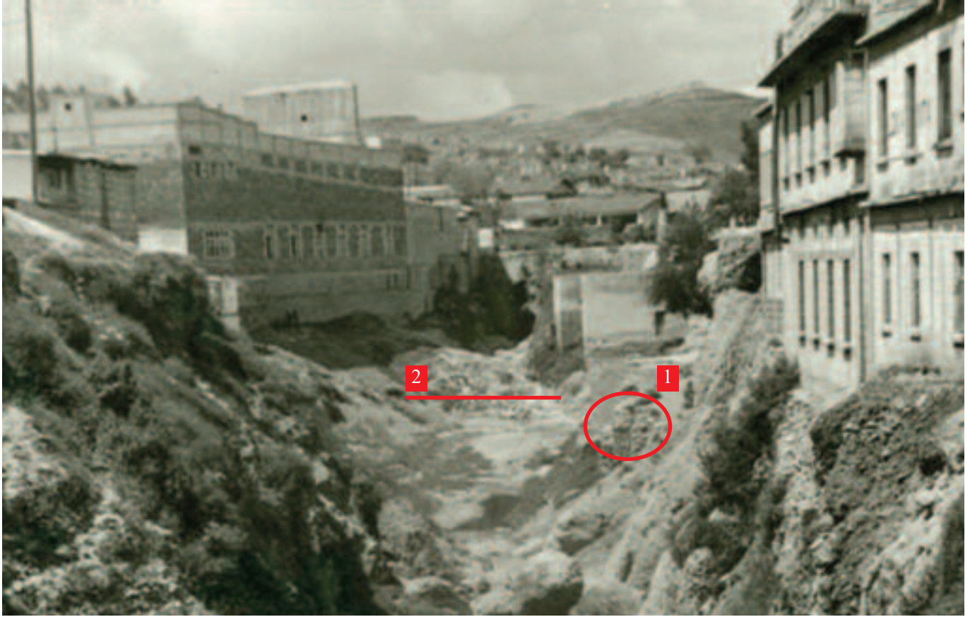
■ Karakoyun Deresi üzerine kurulu değirmenlerden birinin mevkisi. 1-Değirmen binası. 2-Suyun önüne bent yapılarak yükselttilip, değirmen çarkına akıtıldığı nokta.
