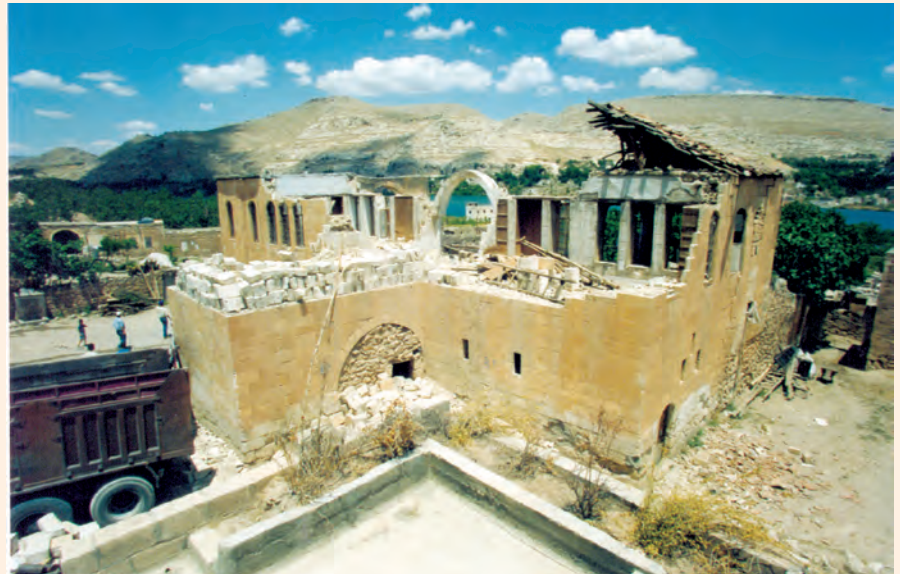
Konağın sökülmesi (Mart 2000)
