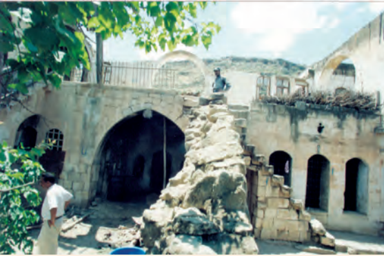
Konağın sökülmesi (Mart 2000)
