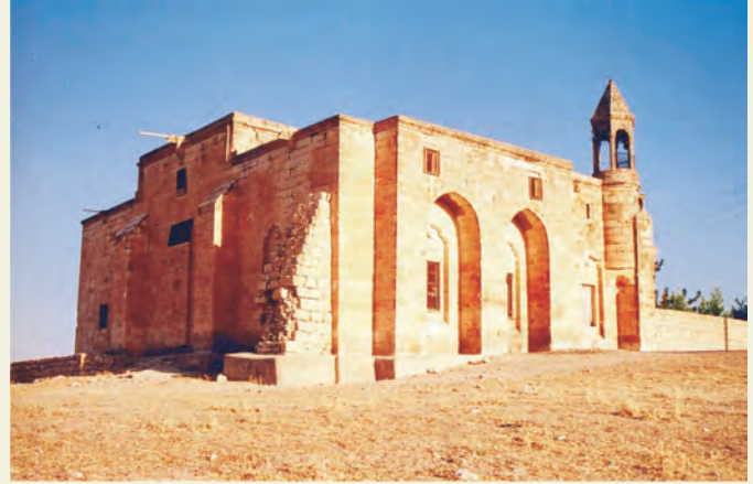
Hüseyin Paşa Camii
