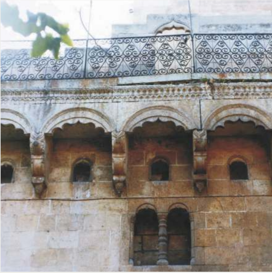
Haşimiye Meydanında Tütüncü Halil Evi Kuş Takaları (Bu yapı yıkılmıştır)
