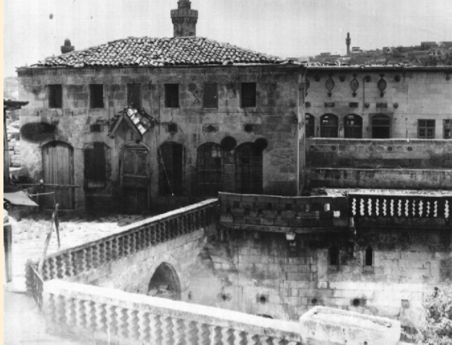
Fotoğraf 9: 1978 yılında Hacı Nuri Uslusoy evi ve gerisinde İsa Beden evi. Her iki ev 1987 yılında yıkılmıştır. Fotoğraf. A. Cihat Kürkçüoğlu
