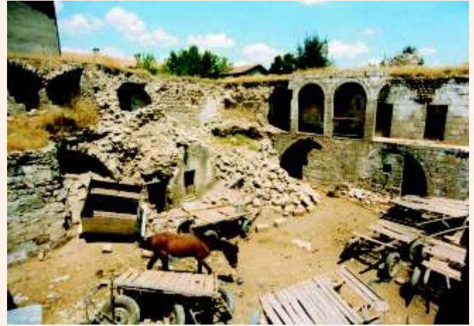
aban Hanı avlusunun kuzeyindeki mekânlar yıkıldıktan sonra (Foto raf: A.Cihat Kürkçüo lu/ 1990).
