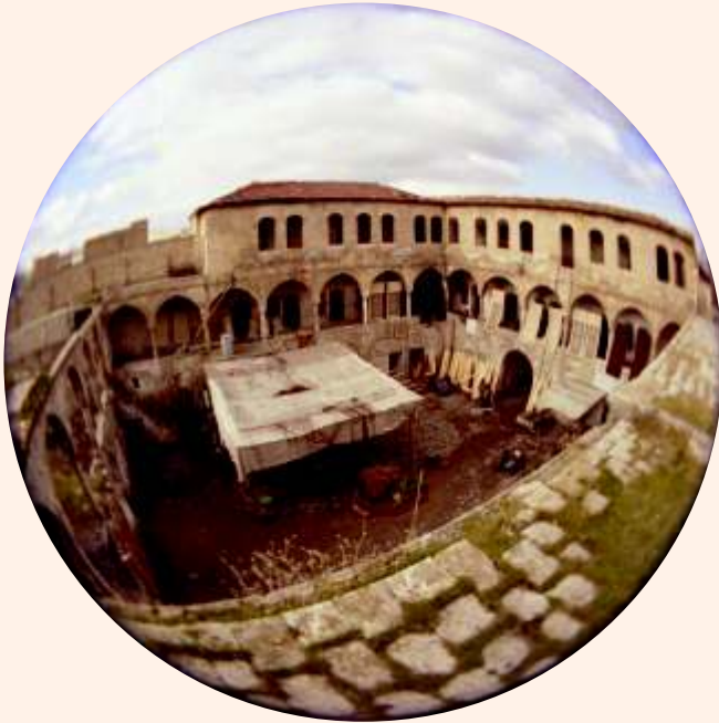
Barutçu Hanı, avlunun kuzeybatı köşesinden görünüm. (Fotoğraf: A.Cihat Kürkcüoğlu/1985).
