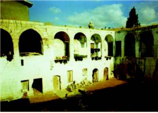
aban Hanı avlusunun kuzeyindeki mekânlar yıkılmadan önce. (Foto raf: A.Cihat Kürkçüo lu/ 1983).
