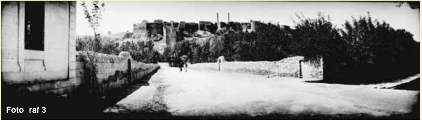
Foto raf 3. Vali Fuat Bey Caddesi'nin (Büyük Yol) Balıklıgöl tarafındaki giriş önünden Urfa Kalesine bakış . Sol tarafta görülen yapı Ethem Paşa tarafından 1903 yılında Urfa'da yaptırılan dört karakoldan biri olan Halil-ür Rahman Karakolu'dur. Diğer üç karakol Bediüzzaman, Halvetiye ve Mihsımor Karakollarıdır. Bu karakollardan sadece Mihsımor Karakolu'nun bir odası günümüze ulaşmıştır.
