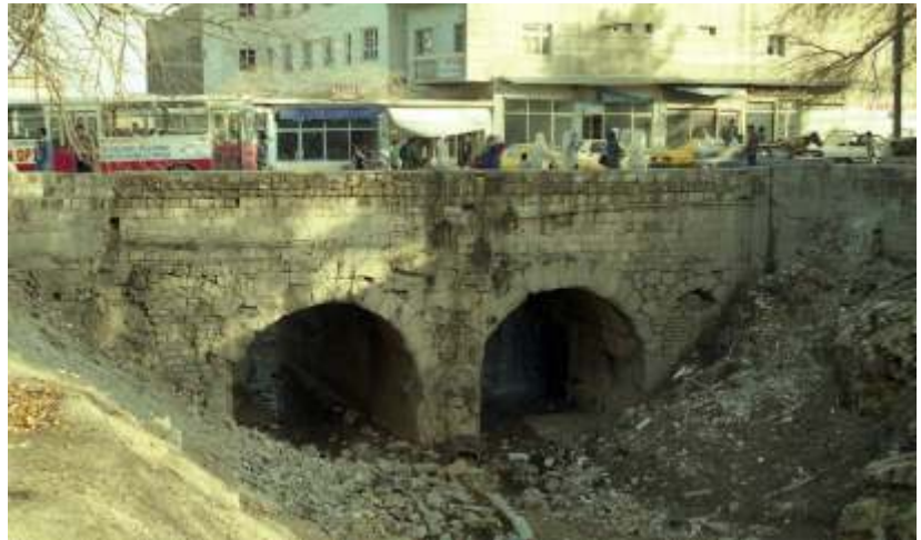
Samsat Köprüsü doğu cephesi.
