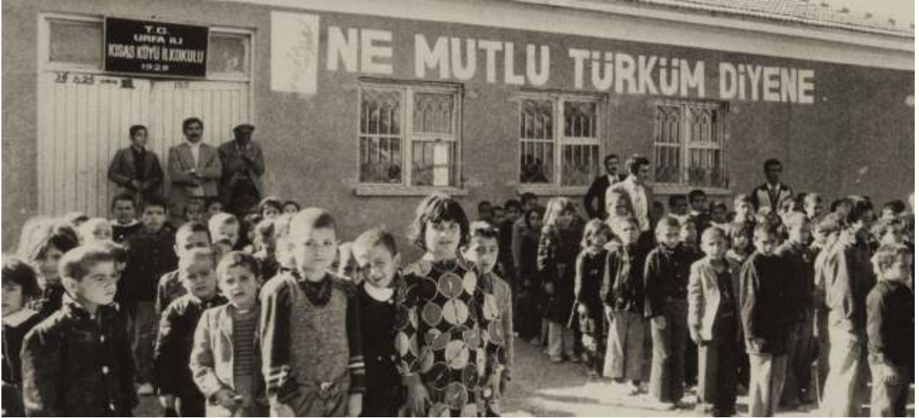
1965-1966 yılında hizmete açılan betonarme ilkokul binası (1975)
