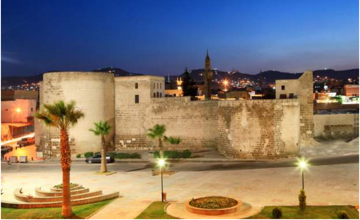
Restorasyonu tamamlanmış hali ile Mahmutoğlu Kulesi doğu cephesi / Fotoğraf: Mustafa Akgül (2013)
