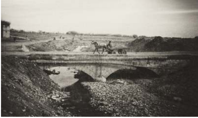
Demirkapı (Bahçeler) Köprüsü (1979 yılı)
