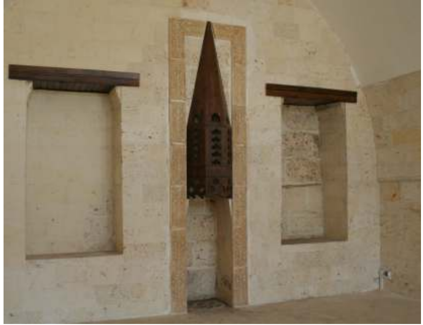
Silindirik kulenin içindeki odalardan birinde olan "Badgir" (Badgir: Doğal klima işlevi gören damla bağlantılı hava kanalı)
