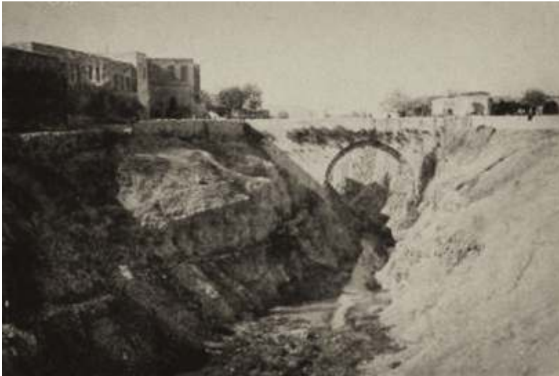
Saray Köprüsü Batı Cephesi. (1900'lı yılların başları- Foto:Max von Oppenheim).
