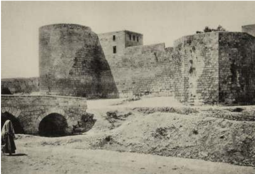
1932 yılında Bey kapısı (Kıyas) Köprüsü ve Mahmutoğlu Kulesi. (Albert Gabriel'den).
