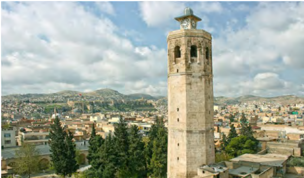
Ulu Cami ve Şehrin Güneyi
