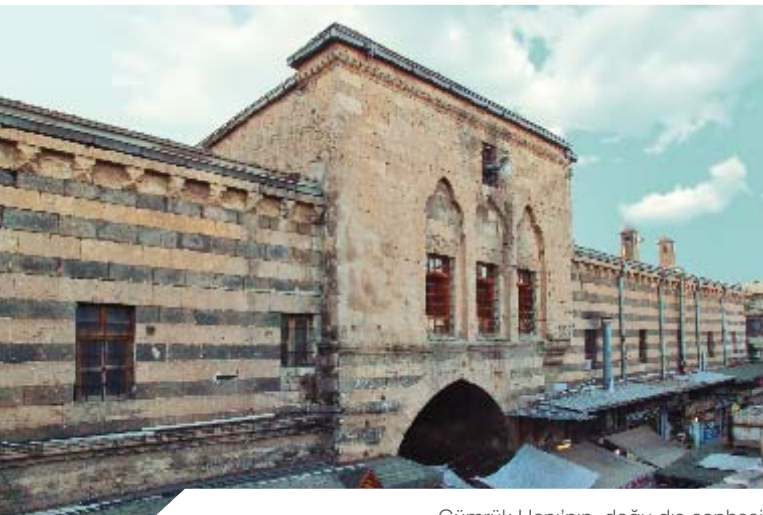
Gümrük Hanı'nın doğu dış cephesi (Ortada mescit yer almaktadır.)
