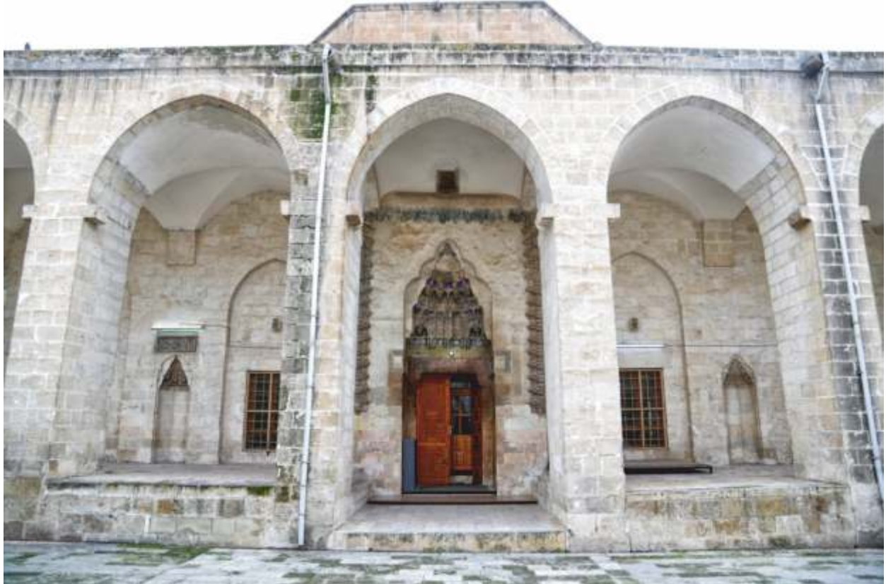
Ni'metullah Camii Kuzey Cephesi
