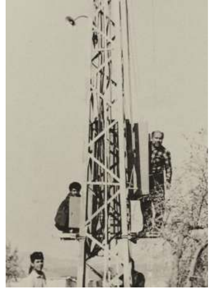
Elektrik arızasına müdahale ederken
