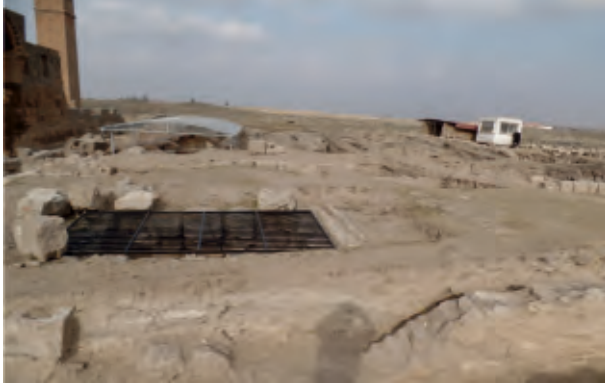
Koruma çalışmalarından görünüm
