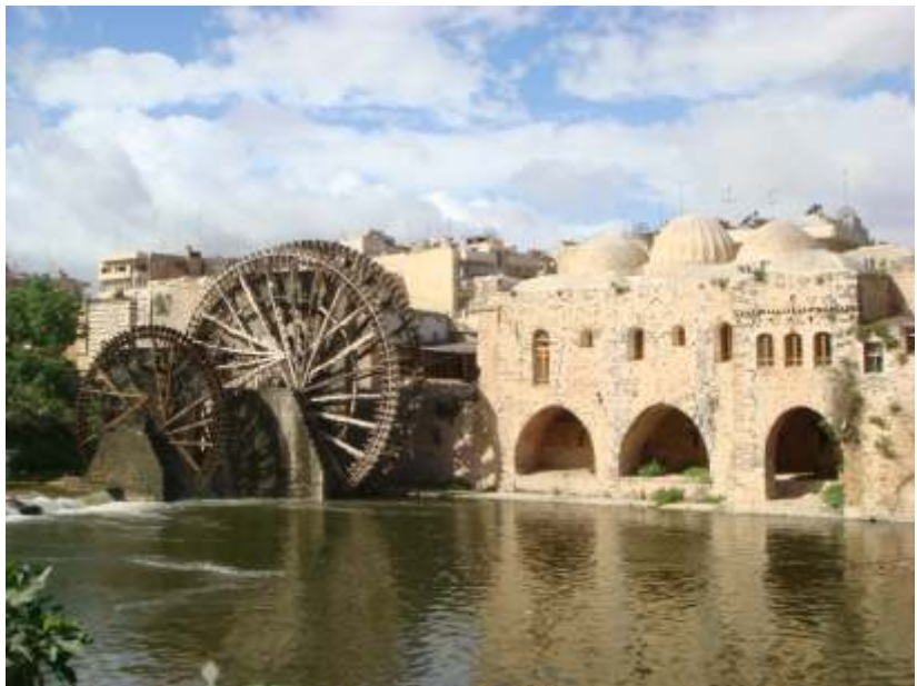
Hama'da, Asi Nehri'nin kenarında su çarkı
