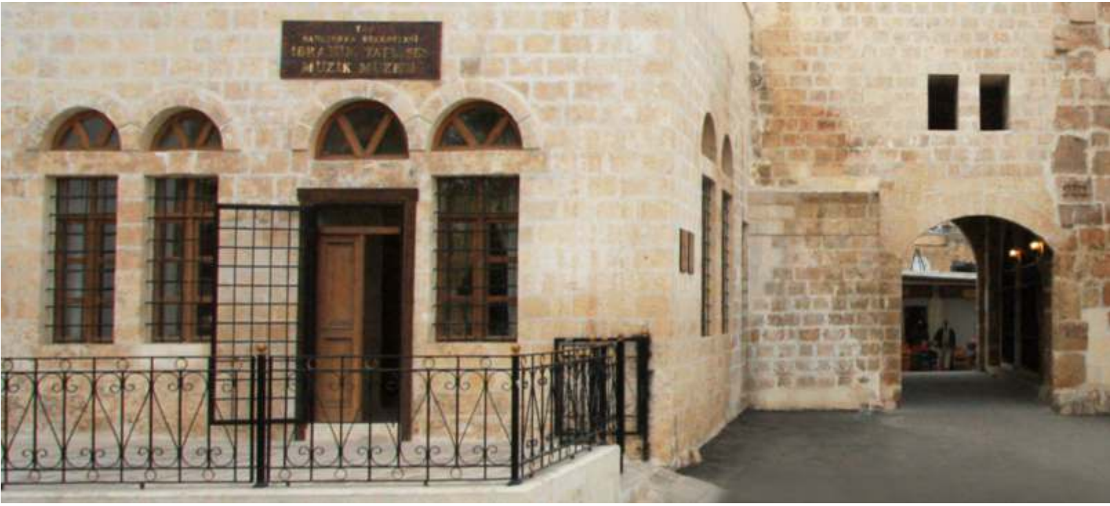
Yasin'in Kahvesi ve Harran Kapısı'nın Güney Cephesi
