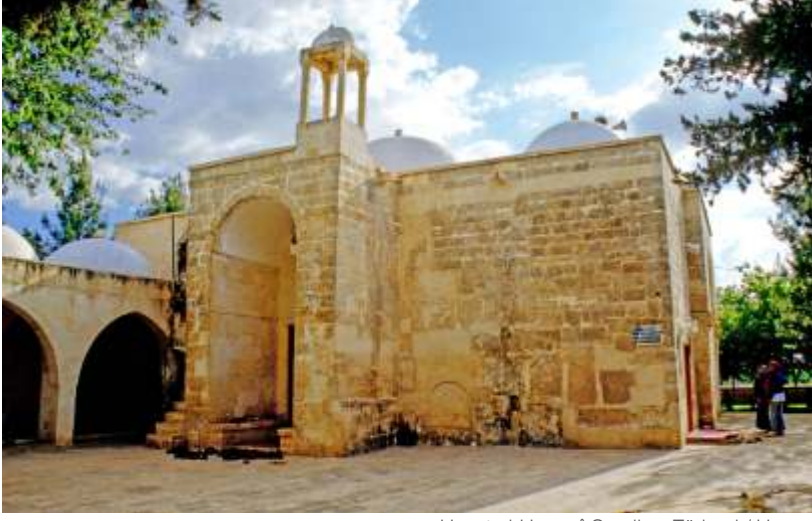
Hayat el-Harranî Camii ve Türbesi / Harran
