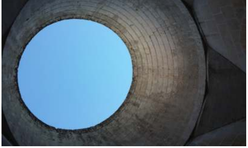
Türbe Avlusunun Kubbesi Gökyüzünü Gören Bir Mimari ile İnşa Edilmiştir.
