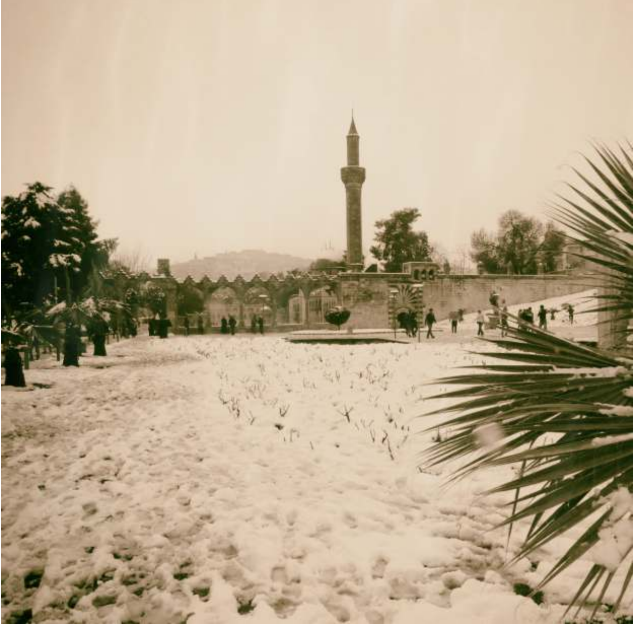
Rizvaniye Külliyesi Doğu Cephesi
