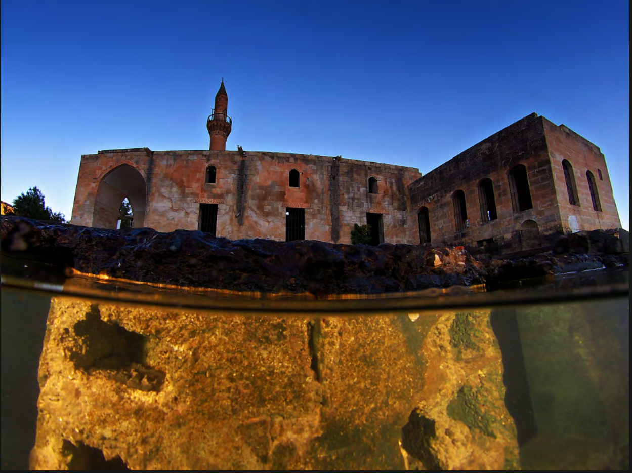
Halfeti Merkez Mahallesinde yarısı sular altında kalan Ulu Camii
