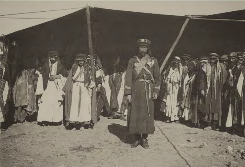
İbrahim Paşa, Çadırının Önünde Askerleriyle / 1899
