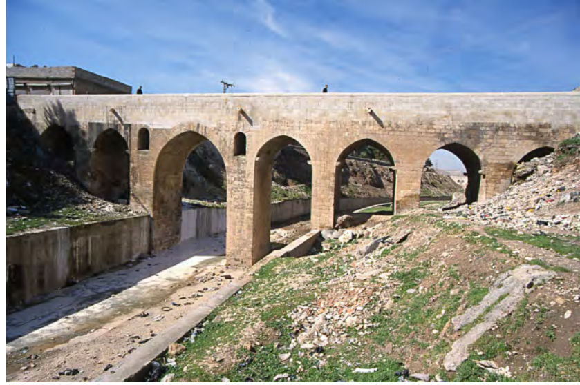
Karakoyun Deresi üzerinde yer alan Millet Köprüsü
