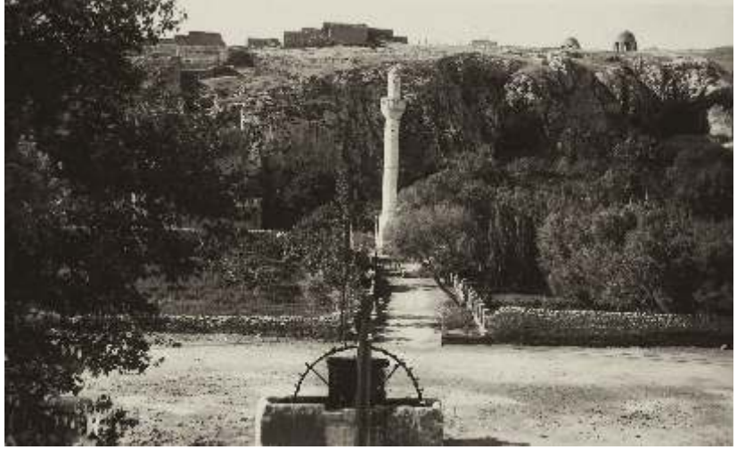
Halil'ür-Rahman Gölü suyunun Mecmelbahr'dan geçişinde yer alan su dolabı
