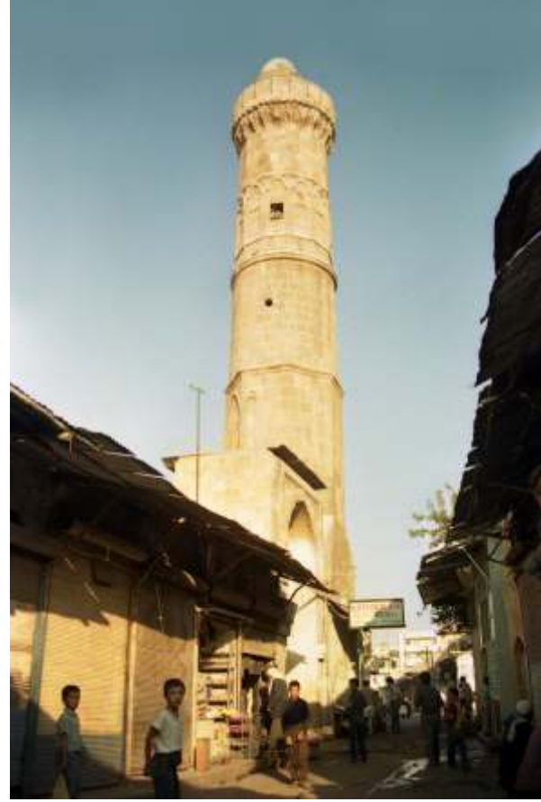
Pazar Camii Kuzey Kapısı
