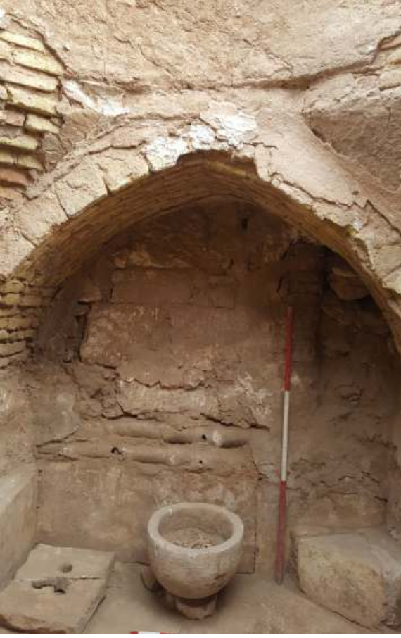
Fotoğraf 14: Kurna ve künk hatlarının görünümü, Saray Hamamı, 2 Nolu Sıcaklık. Harran 2018. Foto: M.Önal
