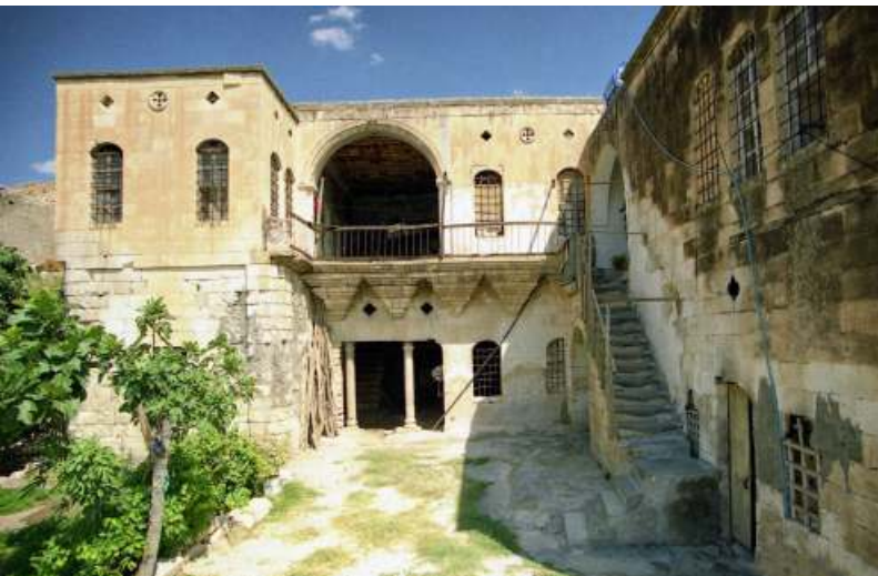
▲ Halfeti Kanneci Konağı Restorasyon öncesi / 1999
