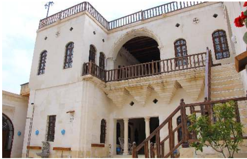
▲ Kanneci Konağı Restorasyon sonrası / 2016
