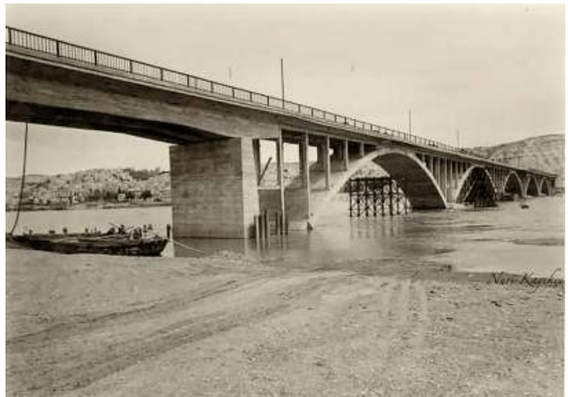
▲ Birecik Köprüsü inşaat çalışmaları devam ederken / 1958
