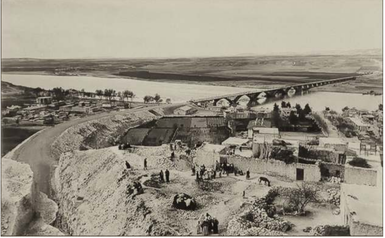
Birecik Köprü İnşa çalışmalarının devam ettiği yıllar
