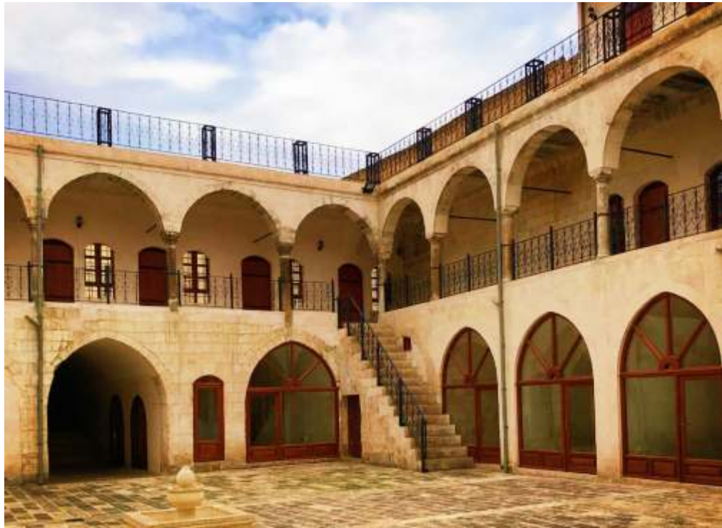
Restorasyon Sonrası Barutçu Hanı / 2018
