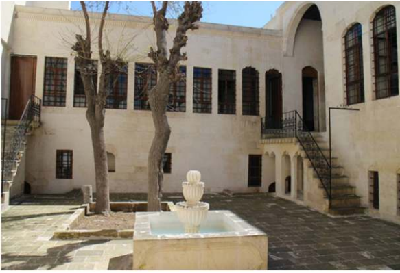
Buluntu Hoca Evi Restorasyonu Öncesi ve Sonrası
