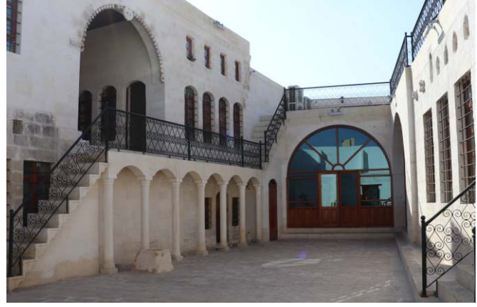
Zaza Konağı Restorasyon Sonrası (Şubat 2021)
