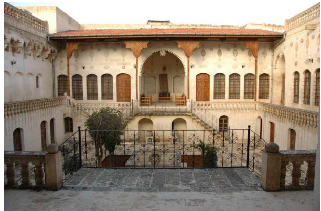
▲ Şahap Bakır Evi (TBMM Egemenlik Evi) Restorasyon Öncesi ve Sonrası
