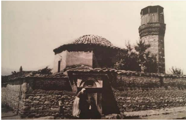
Üsküp Karakapıcı Camii onarımdan önce
