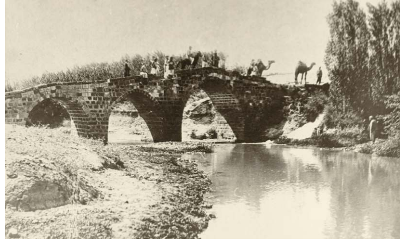
Ek-2 Urfalı Bican Ağa'nın hayrat olarak (günümüzde Suriye topraklarında kalan) Sacur Suyu üzerinde inşa ettirdiği köprü'nün inşaat aşaması ve bitmiş hali
