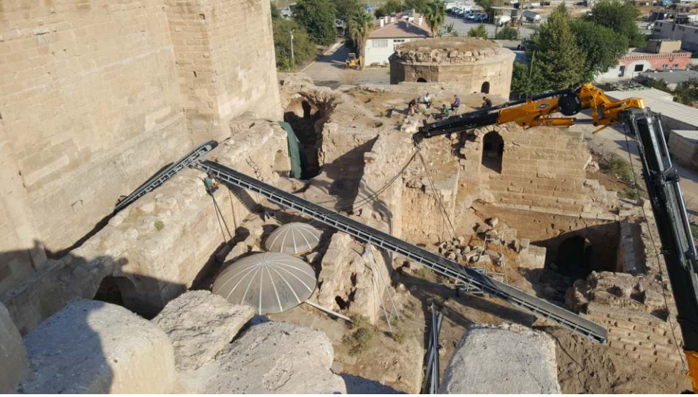
Fotoğraf 13: Taşıyıcı bandın Harran Kalesi'ne yerleştirilmesi. Haran Kalesi 2021. Foto: M. Önal.
