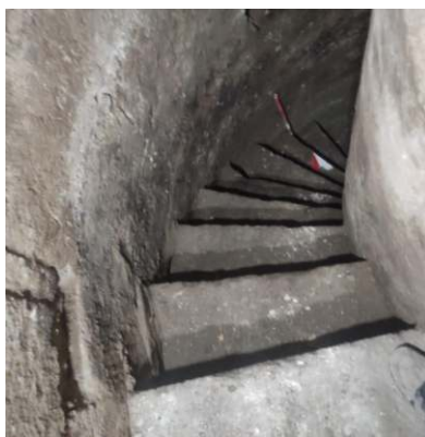
Fotoğraf 8: Merdiven, Batı Kulesi. M. Önal.
