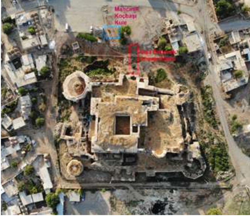
Fotoğraf 17: Harran İçkale köprüsünün yapılacağı yerin üstten görünümü.
