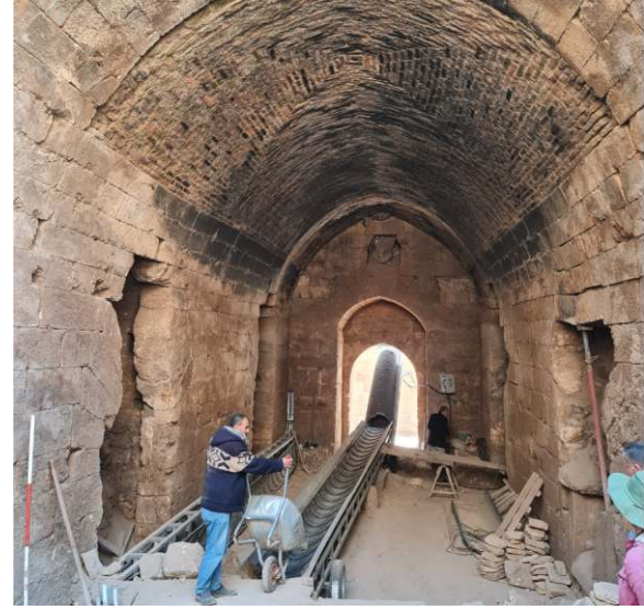
Fotoğraf 14: Kale içinde Taşıyıcı bandın kullanımı / 2021. Foto: M. Önal.
